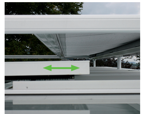
(1) Lüftung auch unter einer ausgefahrenen Markise
